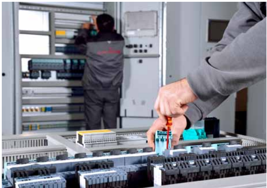
► Montage der neuen Schaltschränke
