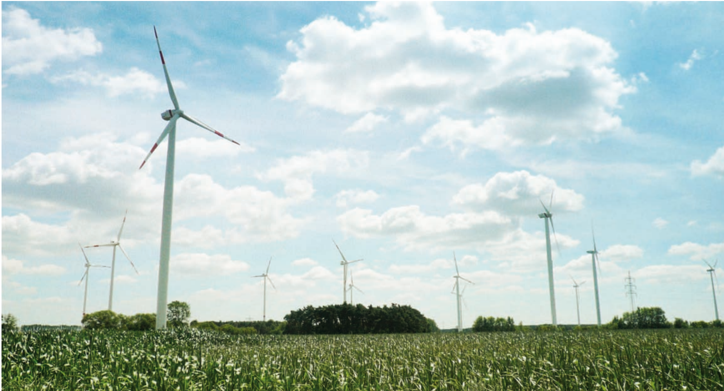
► eno Windturbinen leisten einen Beitrag zur Netzstabilität und Netzstützung
