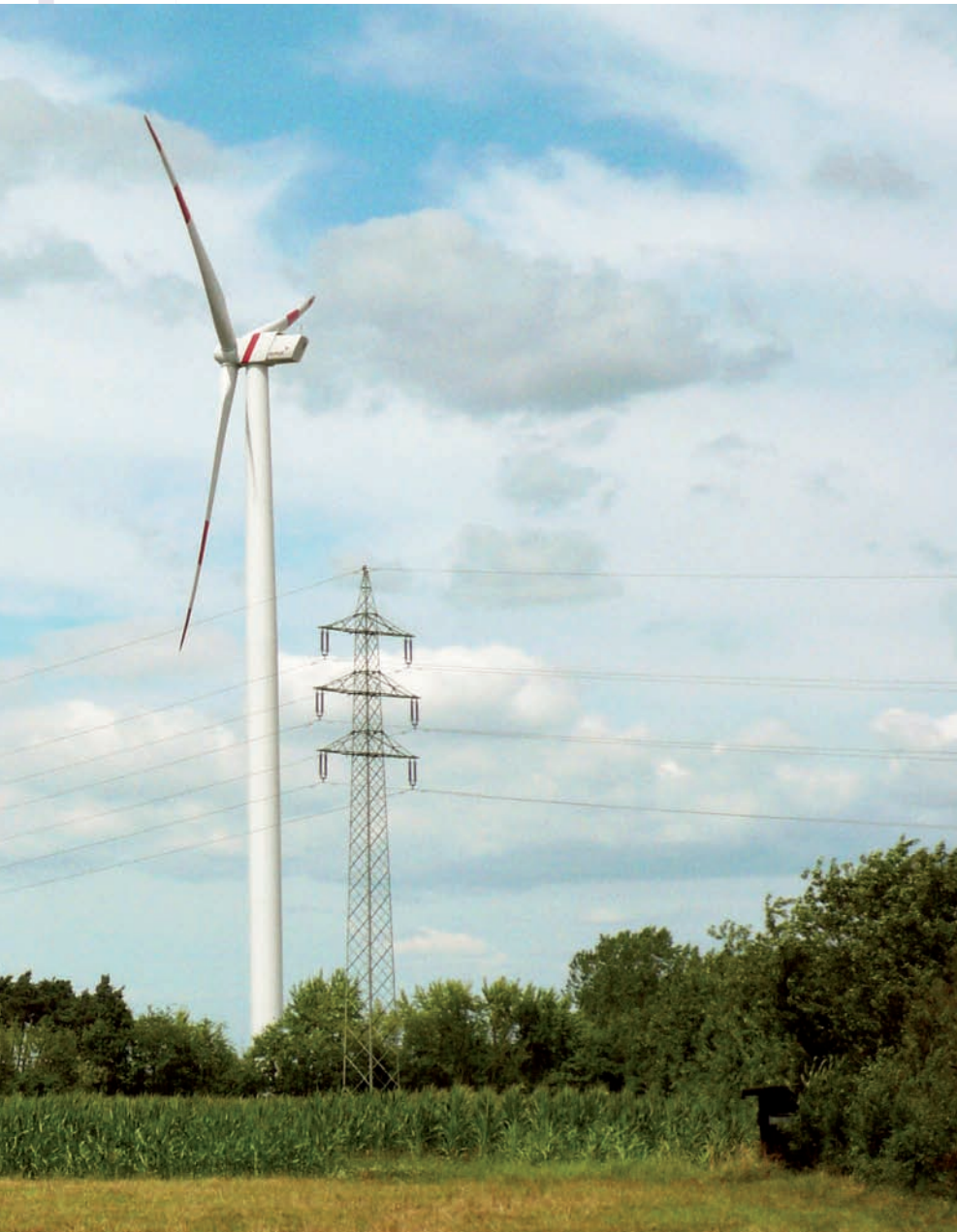
► Windpark Kauxdorf – zertifizierter Netzanschluss für eno Anlagen der 2 MW-Plattform
