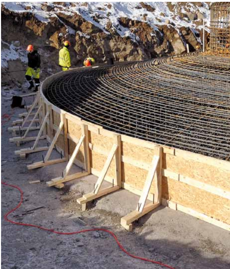
▼ Baustelle der e.n.o. energy
