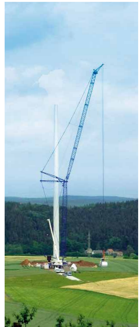
▲ Baustelle e.n.o. energy
